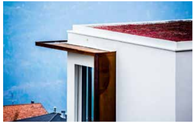
Foto 7 - Prospetto con dettaglio di copertura
