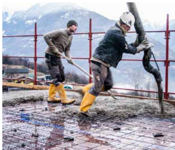
Foto 1 - Getto del calcestruzzo su solaio
