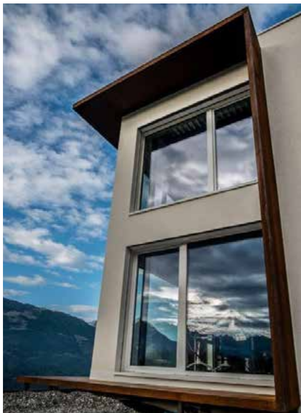
Foto 4 - Vista della facciata vetrata
