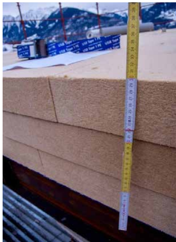
Foto 3 - Pannelli isolanti in fibra di legno da 30 cm
