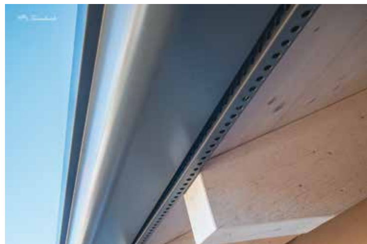
VENTILAZIONE NASCOSTA. Dettaglio
