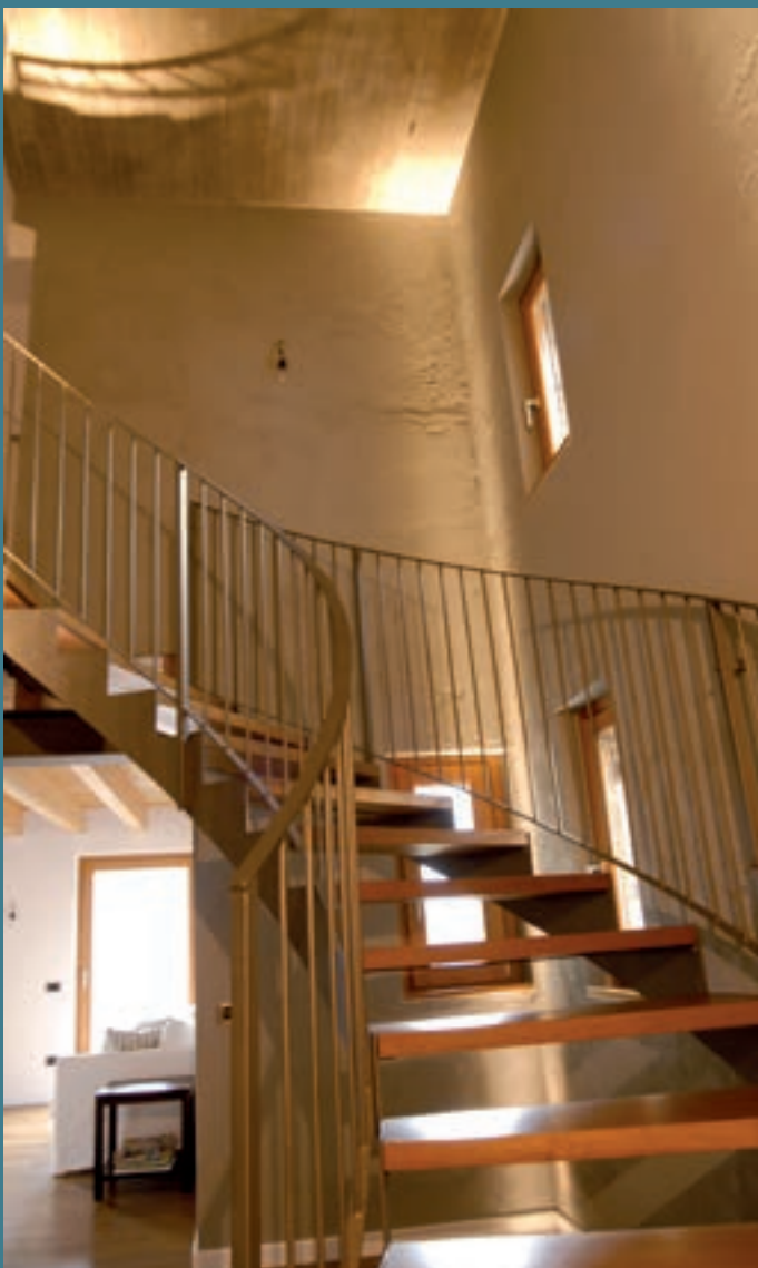
ACCESSO ALLA ZONA NOTTE. Scala elicoidale in ferro e legno
