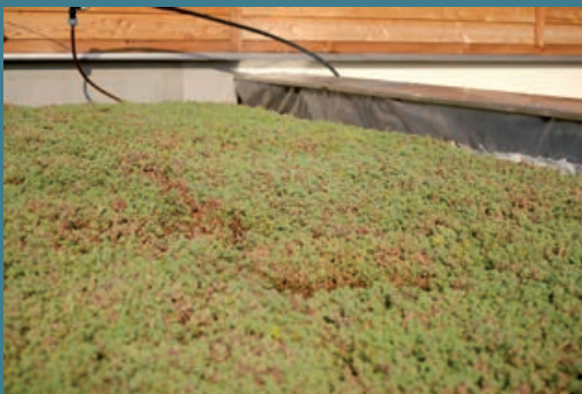
COPERTURA A VERDE realizzata con quattro varietà di Sedum , pianta rustica della zona molto resistente agli stress idrici e agli sbalzi di temperatura
